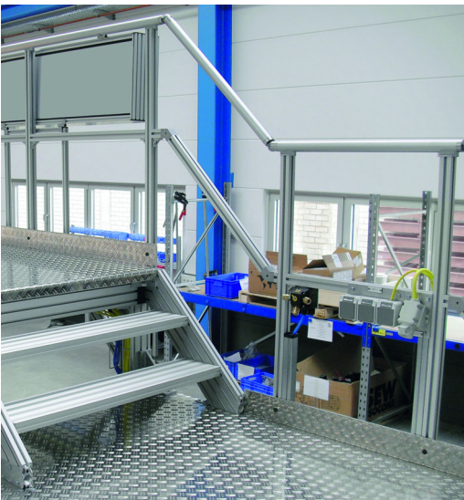
Montagebühne, einseitig durch Geländer abgesichert
