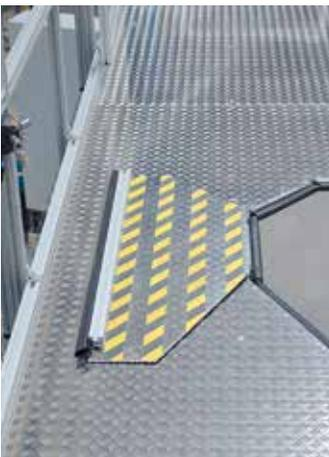
**Montageklappe im Podestboden mit Antirutschbelag auf der Unterseite**
