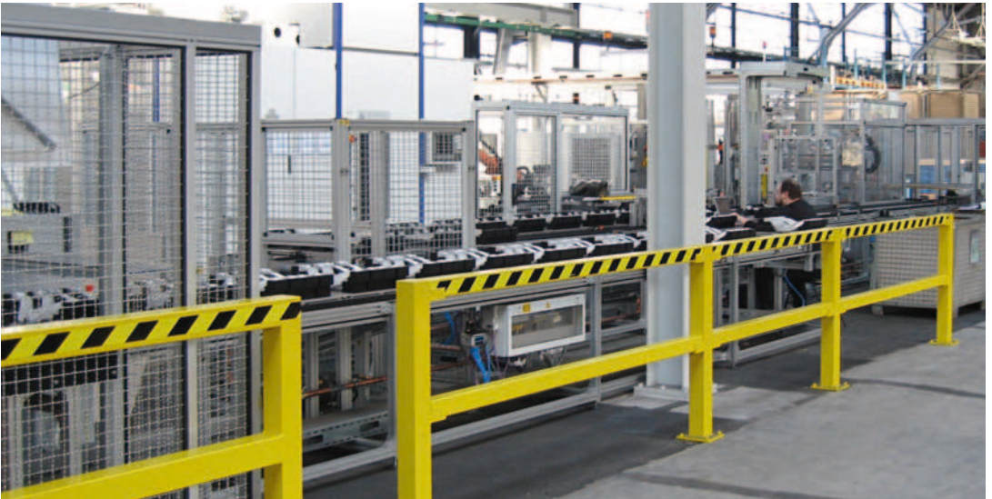
Verkettung von Fertigungszellen im Automotivebereich. Manuelle WT Bestückung, Entnahme mit kunds. Handling und Roboter. Untere Rückführebene mit Lift und Shuttle.
